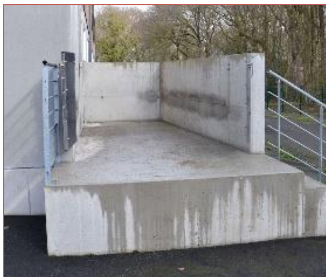
Figura 3.4. Muelle de carga de cemento sólido en una granja puede facilitar las operaciones de carga.
